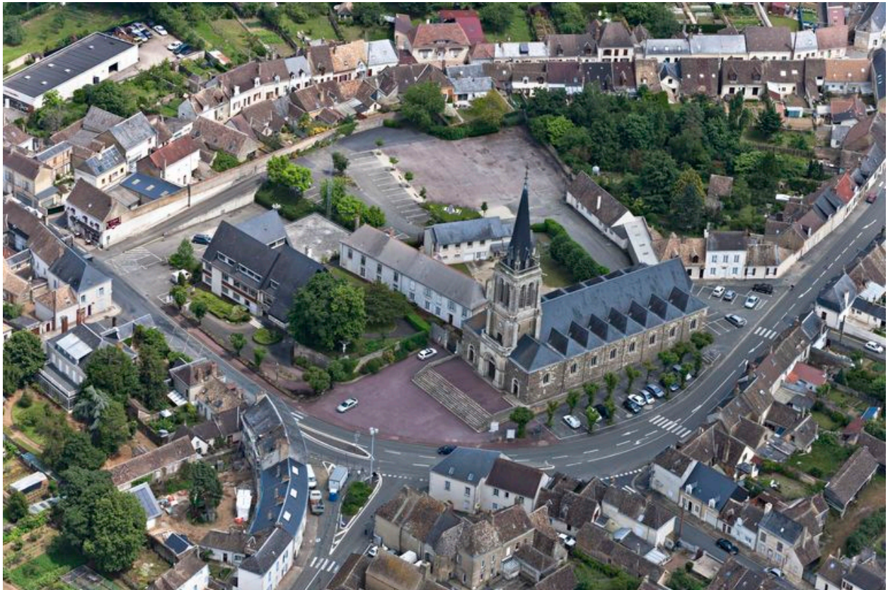
Vue aérienne de l'église et du presbytère depuis le sud-ouest.
