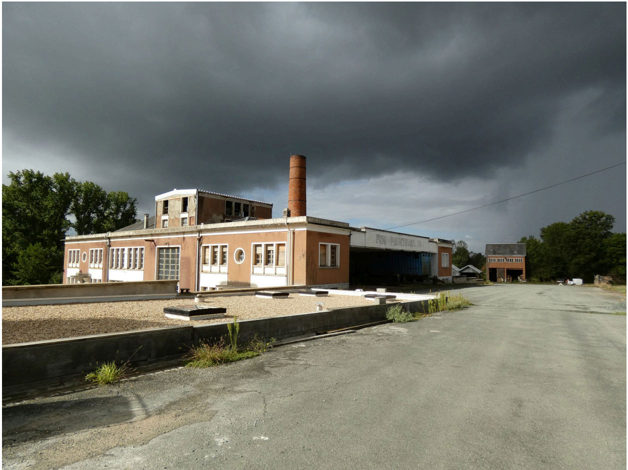
La laiterie vue depuis le nord-est. Au premier plan, les anciens réservoirs à essence.
