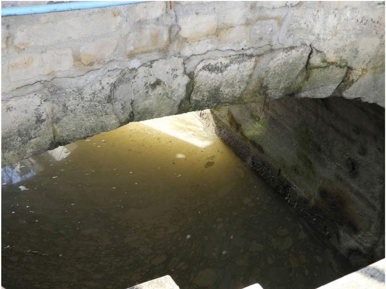
Détail du pertuis en pierre de taille sous le pont.
