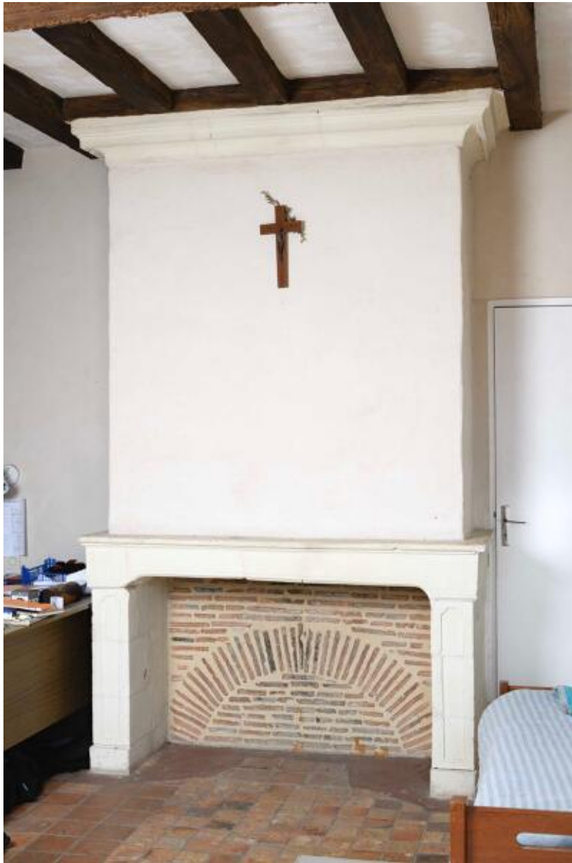
Détail de la cheminée de la chambre sud-ouest.
