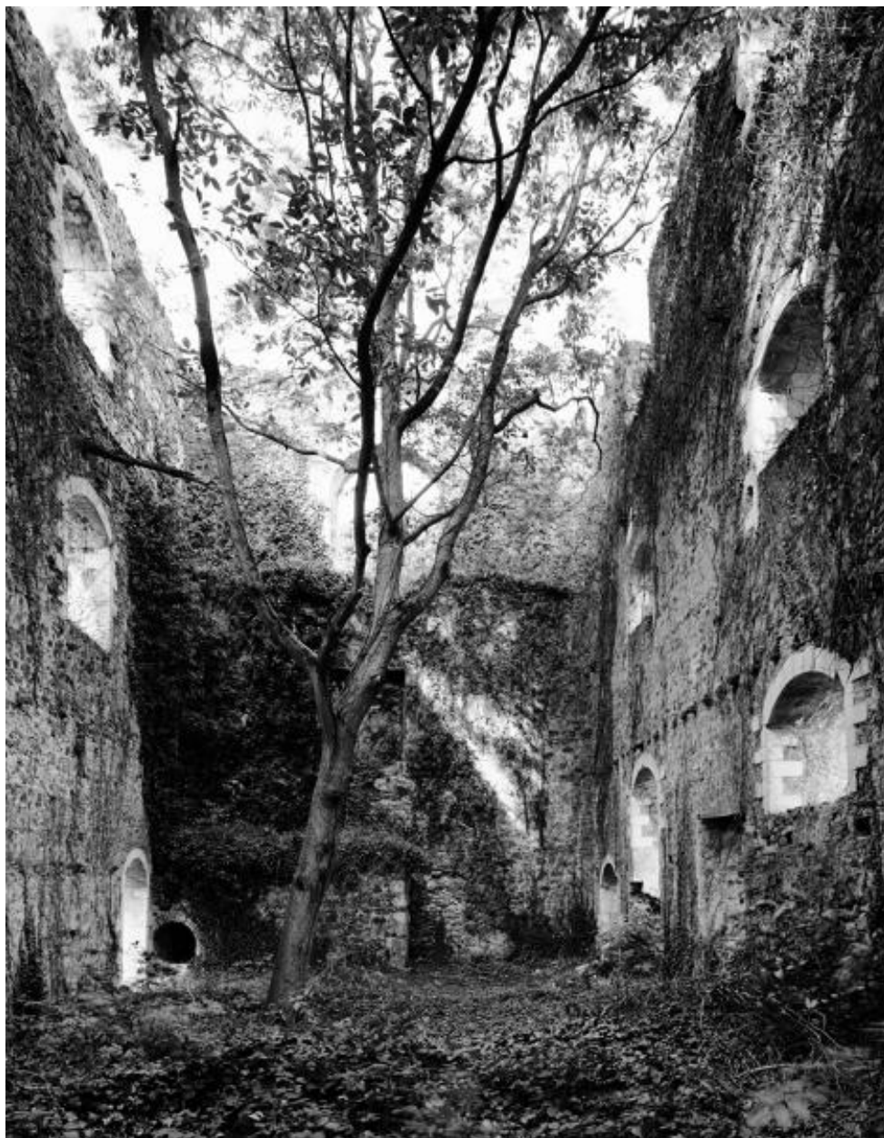
Intérieur de la grande salle du bâtiment est, vue du sud-est vers le nord-ouest, four de Sainte Barbe, Montjean-sur-Loire.
