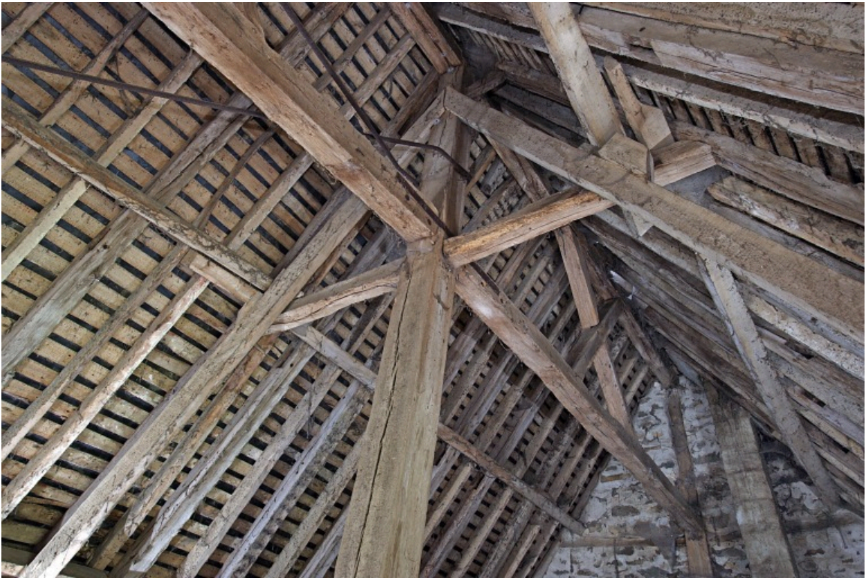
Le logis, charpente. Le contreventement de la partie sud.
