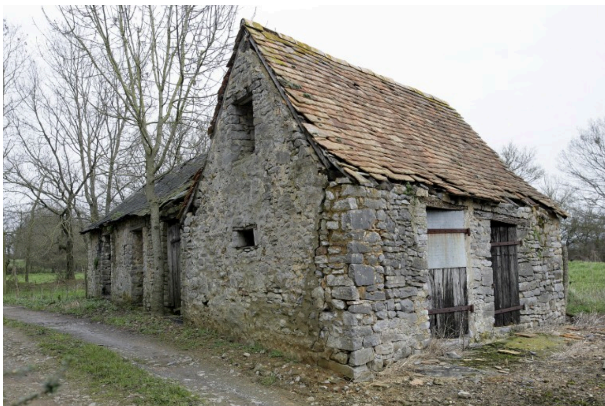
La porcherie vue depuis le sud-ouest.
