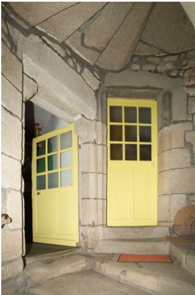
Cage d'escalier, palier du premier étage, porte ouvrant vers les salles sur rue.
