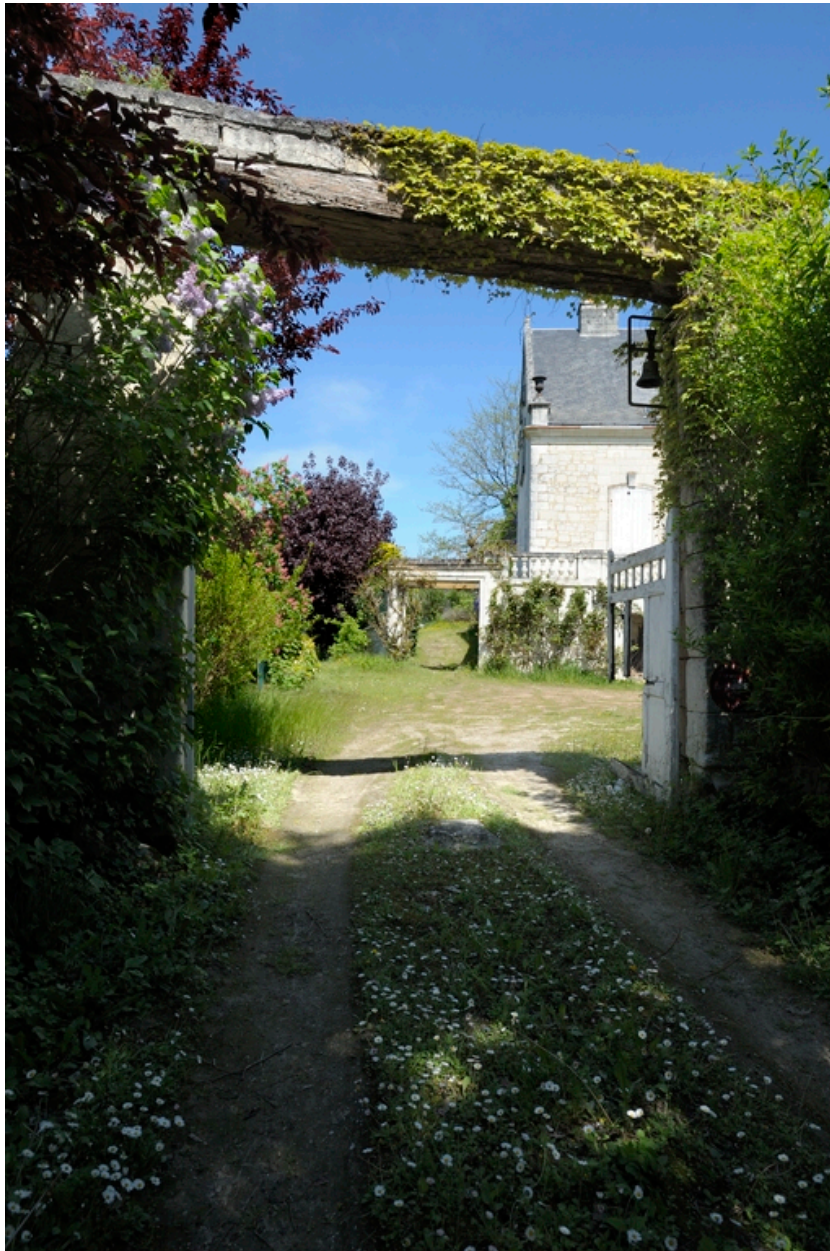
Porte d'accès sud au domaine, depuis la vallée de l'Arceau.
