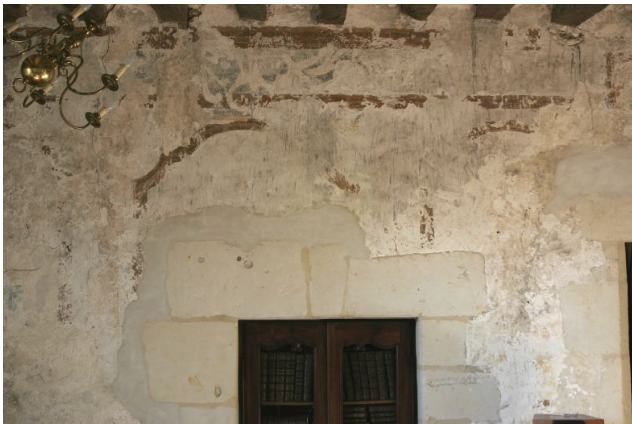
Rez-de-chaussée, mur de refend : vestiges de peintures murales.
