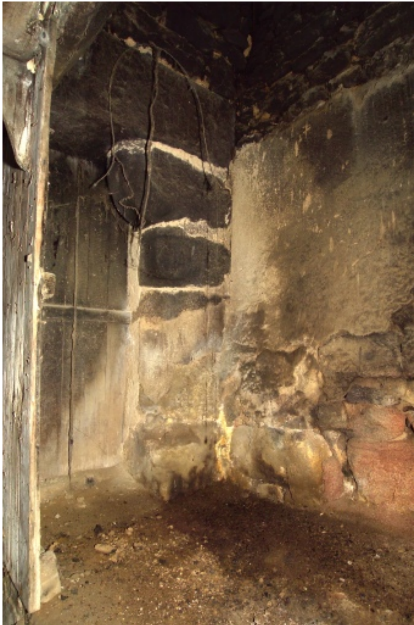
Bâtiment sud, détail piédroit cheminée.
