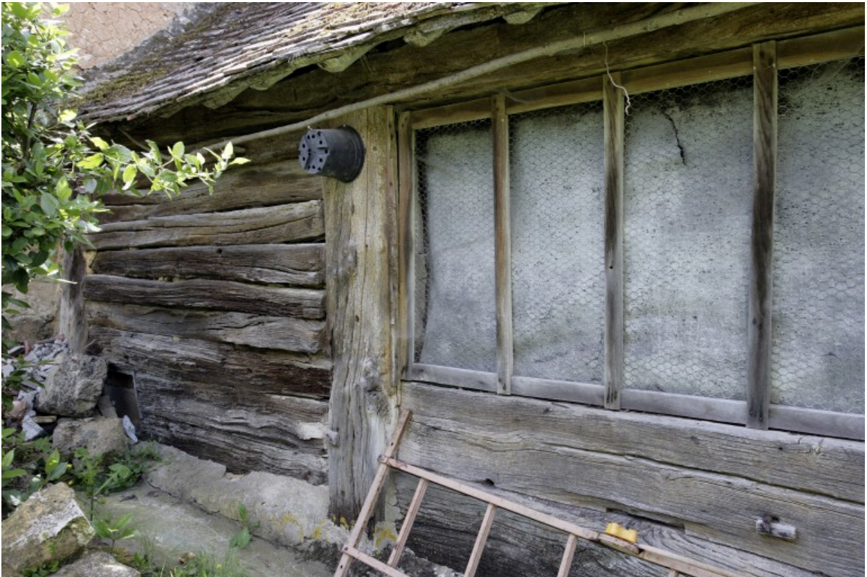
Remise, élévation postérieure : mur en bois.
