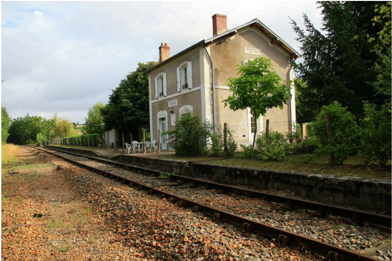
La gare de Chenu en 2008 : une voie.
