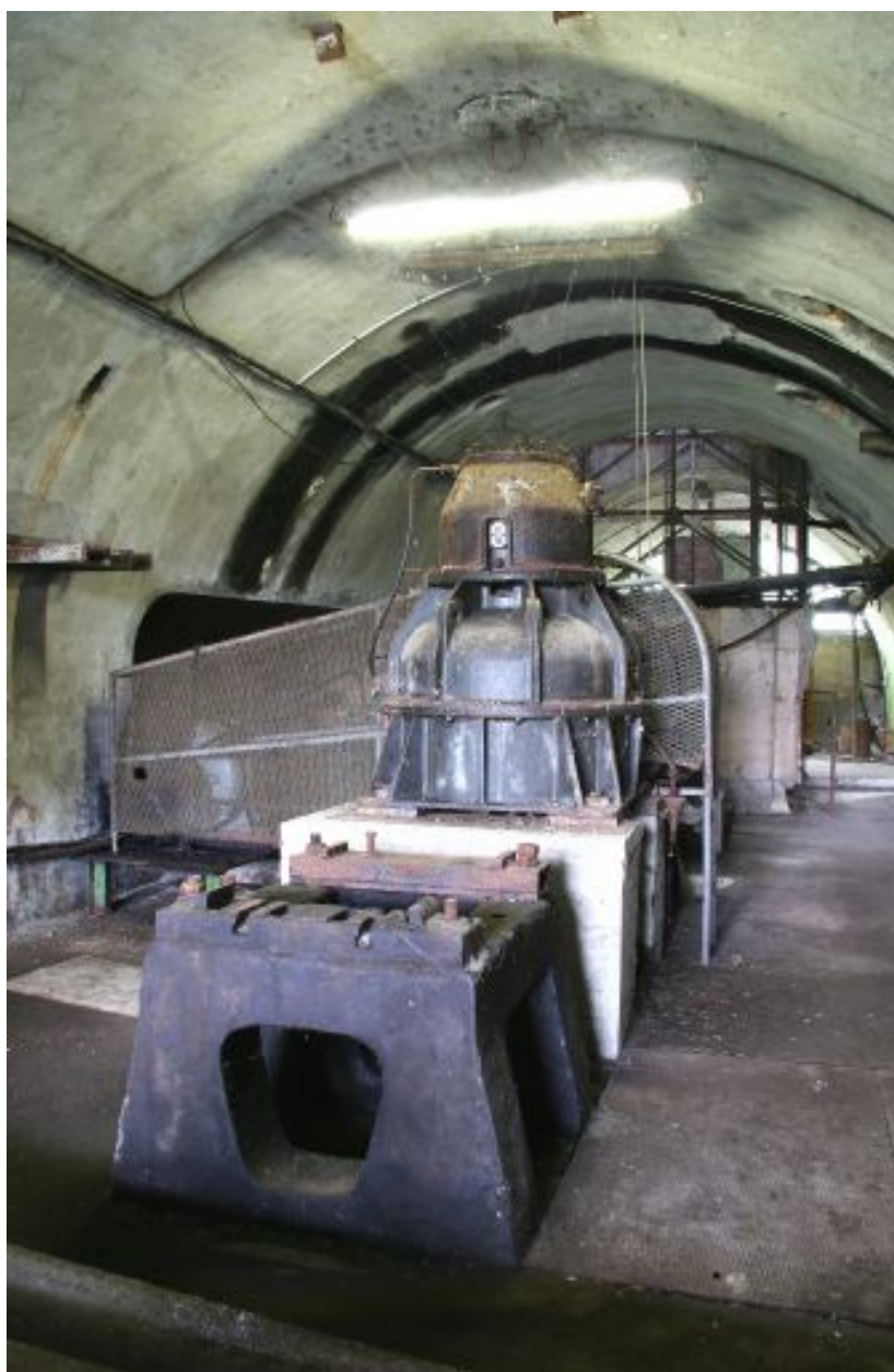
Rez-de-chaussée, 3e vaisseau transversal : réducteur.
