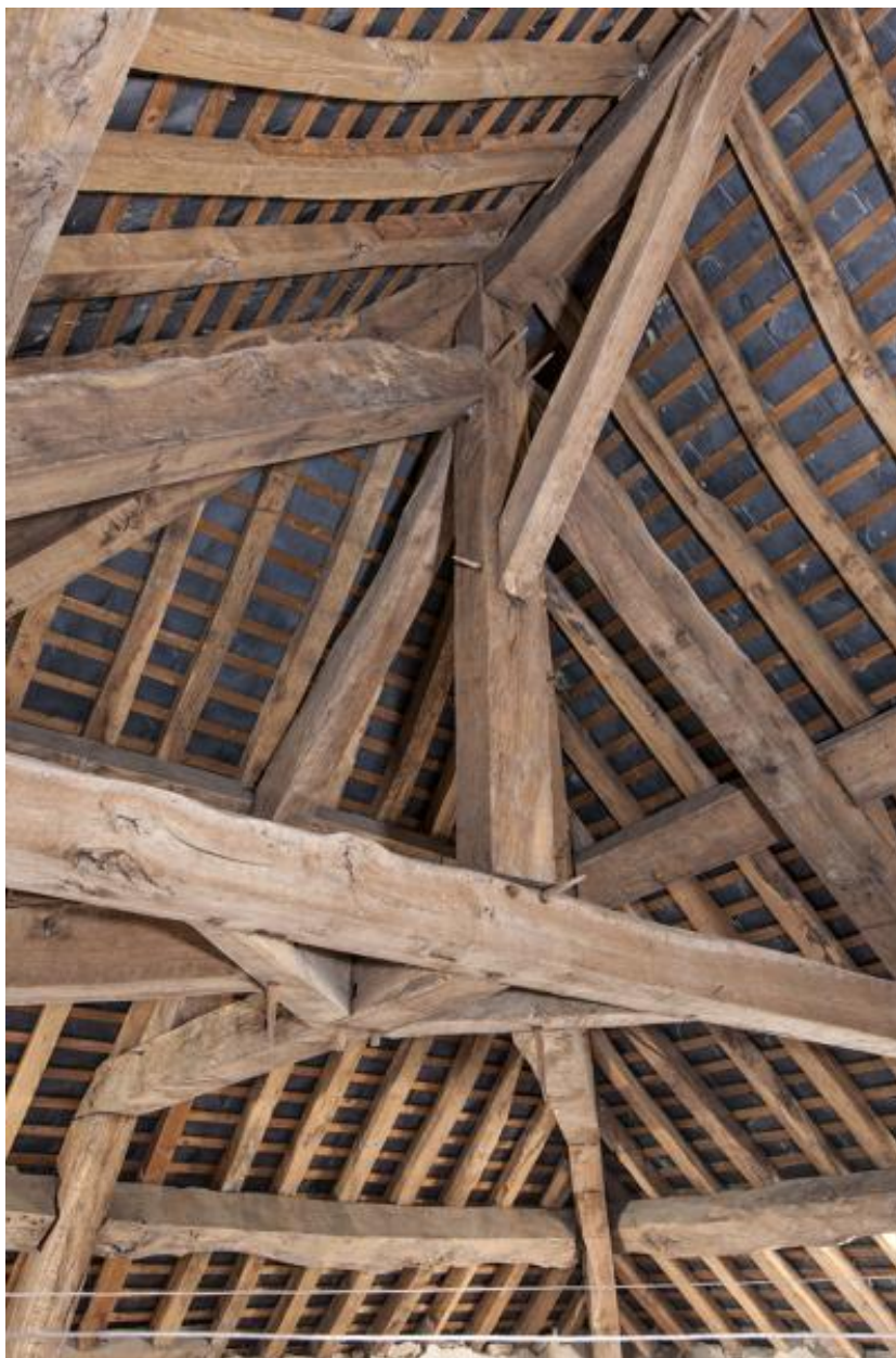
Charpente du château de la Drouardière.
