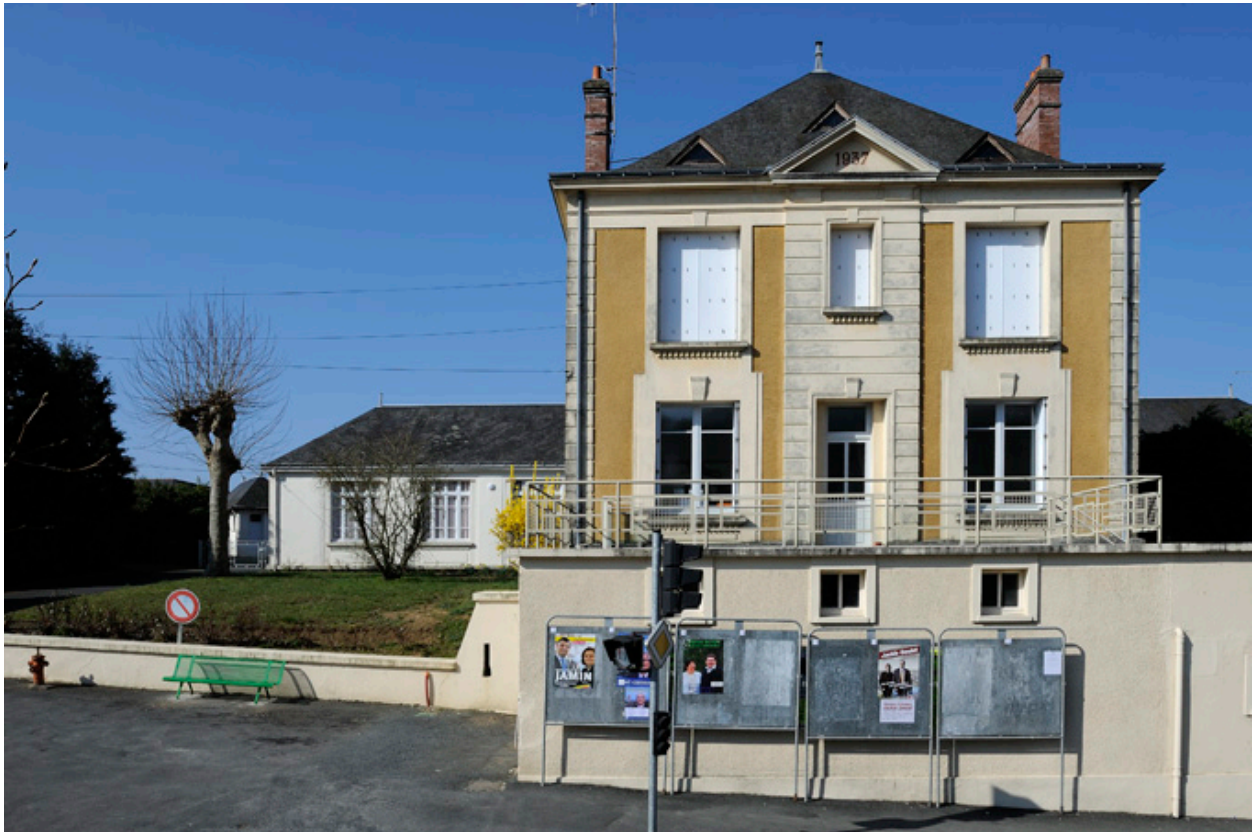
Maison du directeur : façade principale
