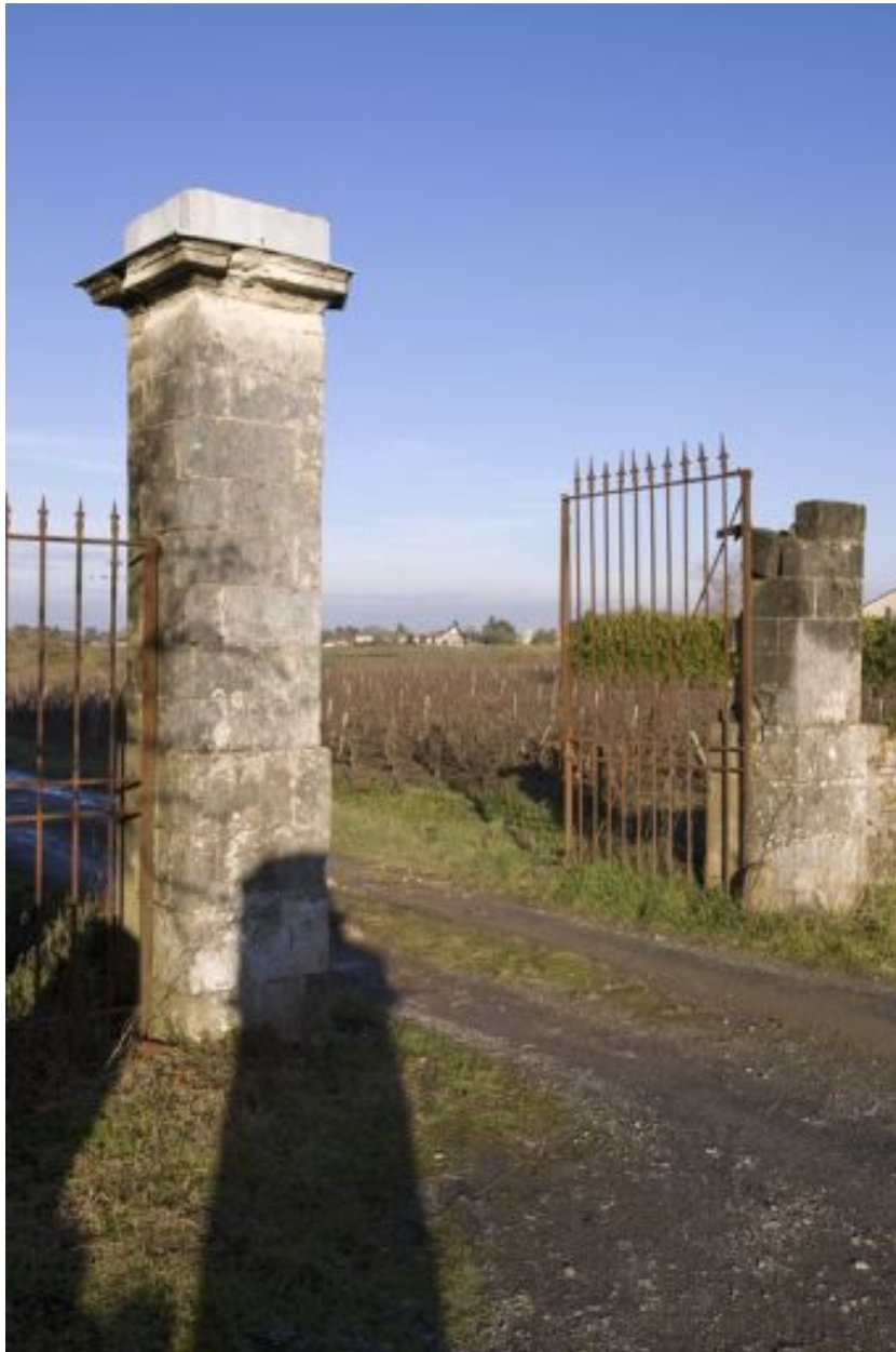
Portail d'entrée : détail de la grille. 19e siècle.
