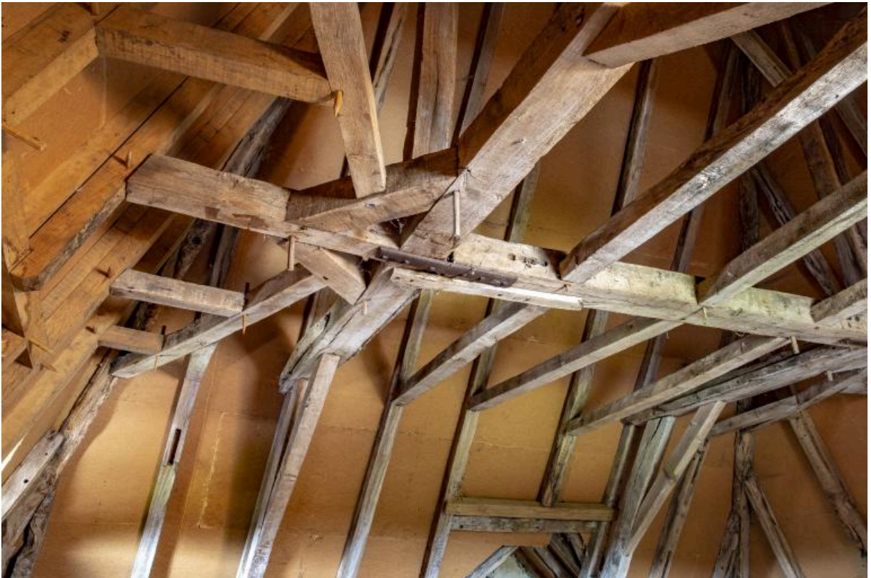
La charpente du pavillon.
