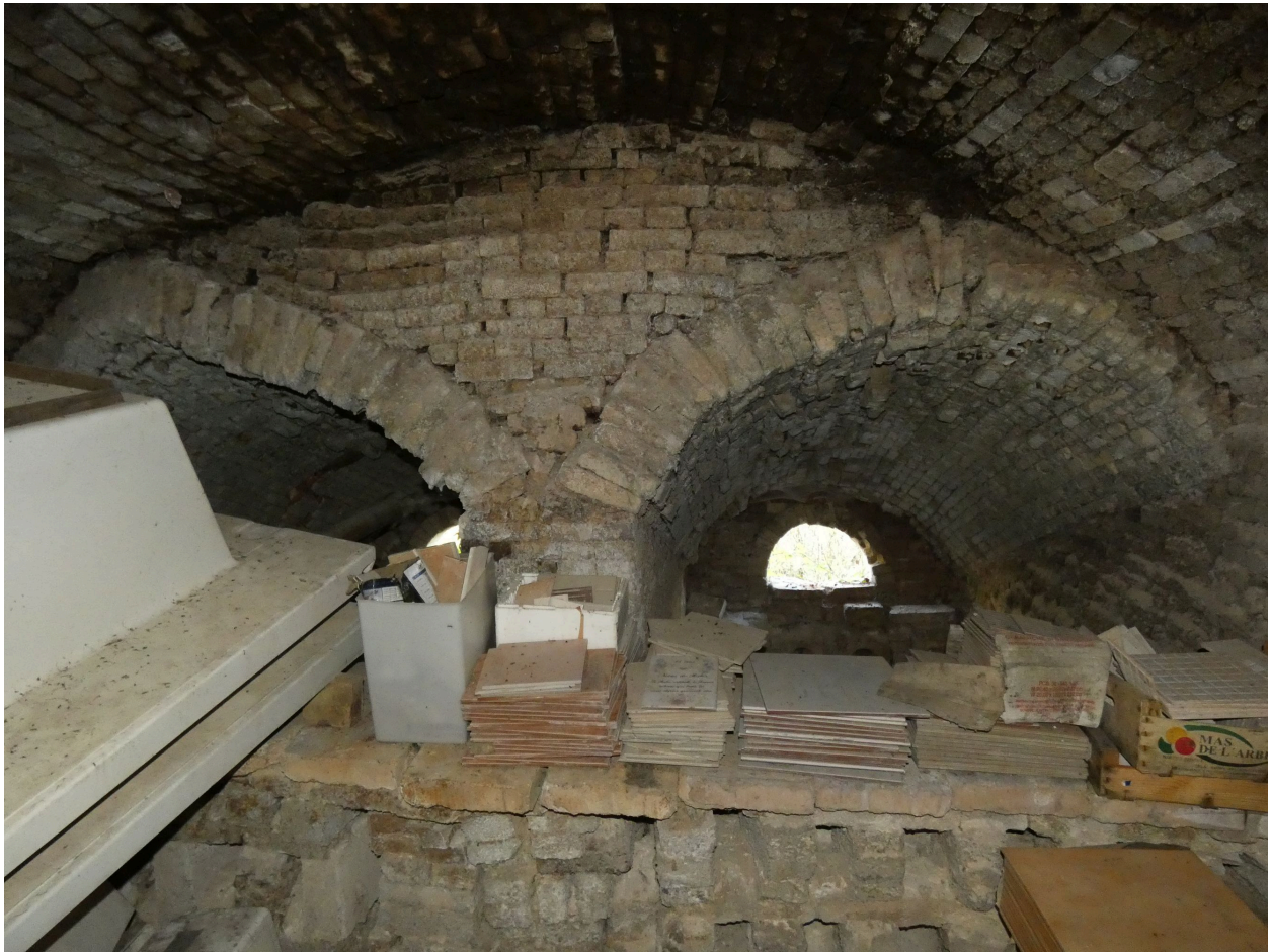
Les deux foyers du premier four, vus depuis le sud.
