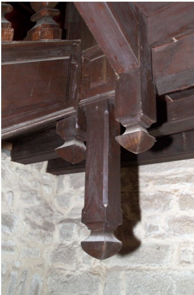
Détail des poinçons pendants de l'escalier.
