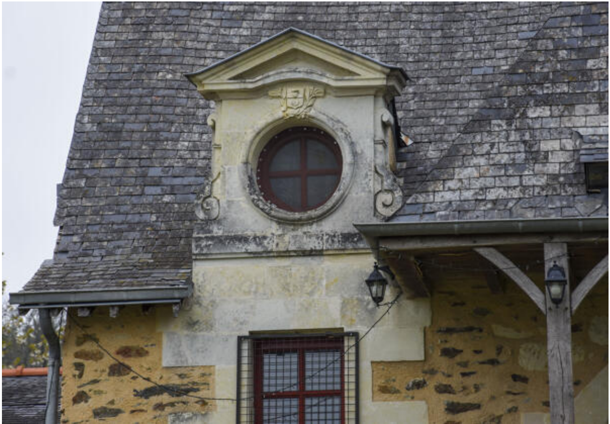
Le logis, détail d'une lucarne.
