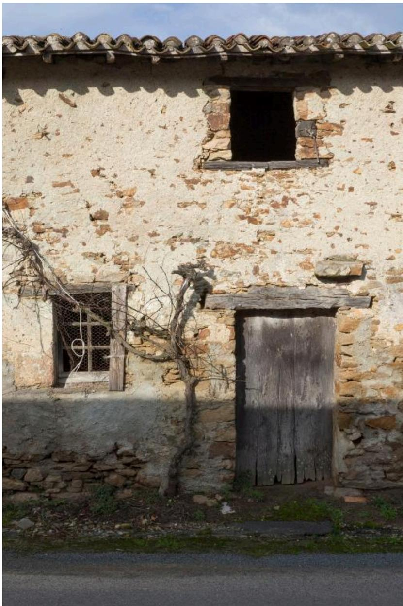
Façade principale d'une ancienne habitation. Les murs sont en pierre de schiste montés à la terre. Les baies et la porte sont surmontées d'un linteau de bois. La Mauvillonnière, La Planche.
