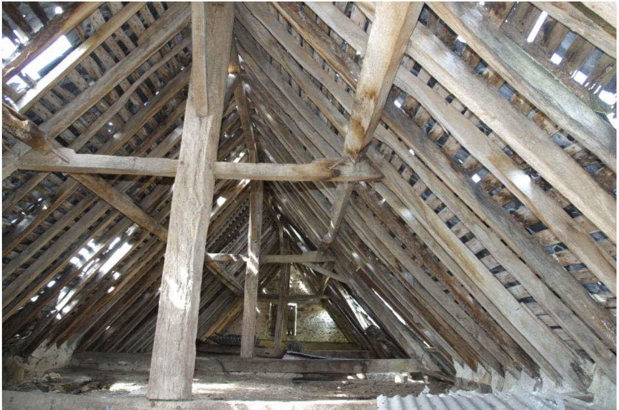
L'ancien logis-étable : la charpente.
