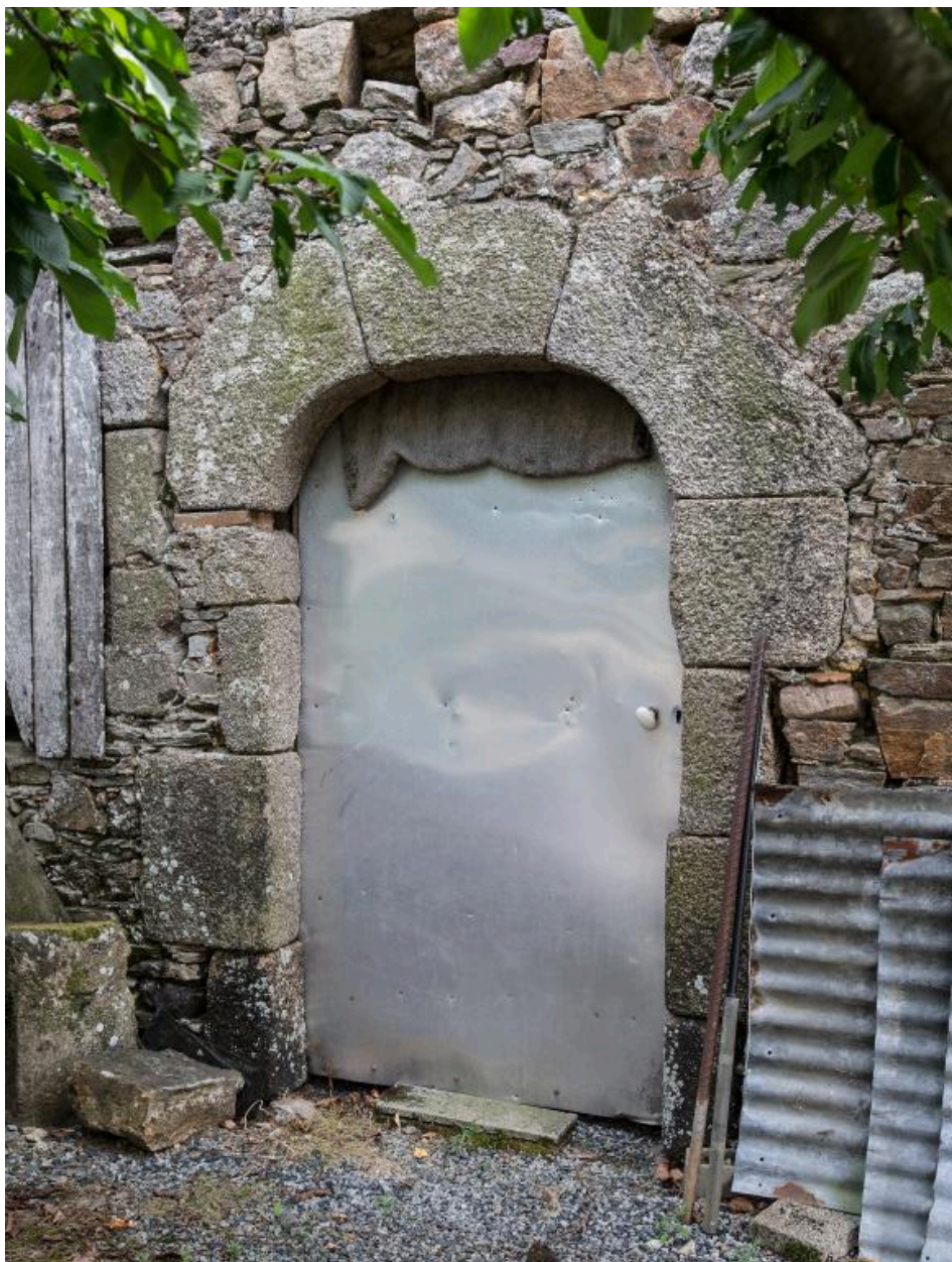
Porte en blocs de granite grossièrement taillés en arc anse-de-panier. La Grande Brosse, Vieillevigne.
