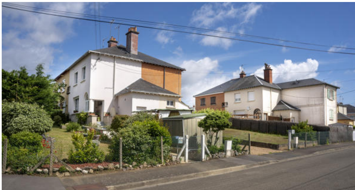
Vue des pavillons rue de Brindejonc des Moulinais.
