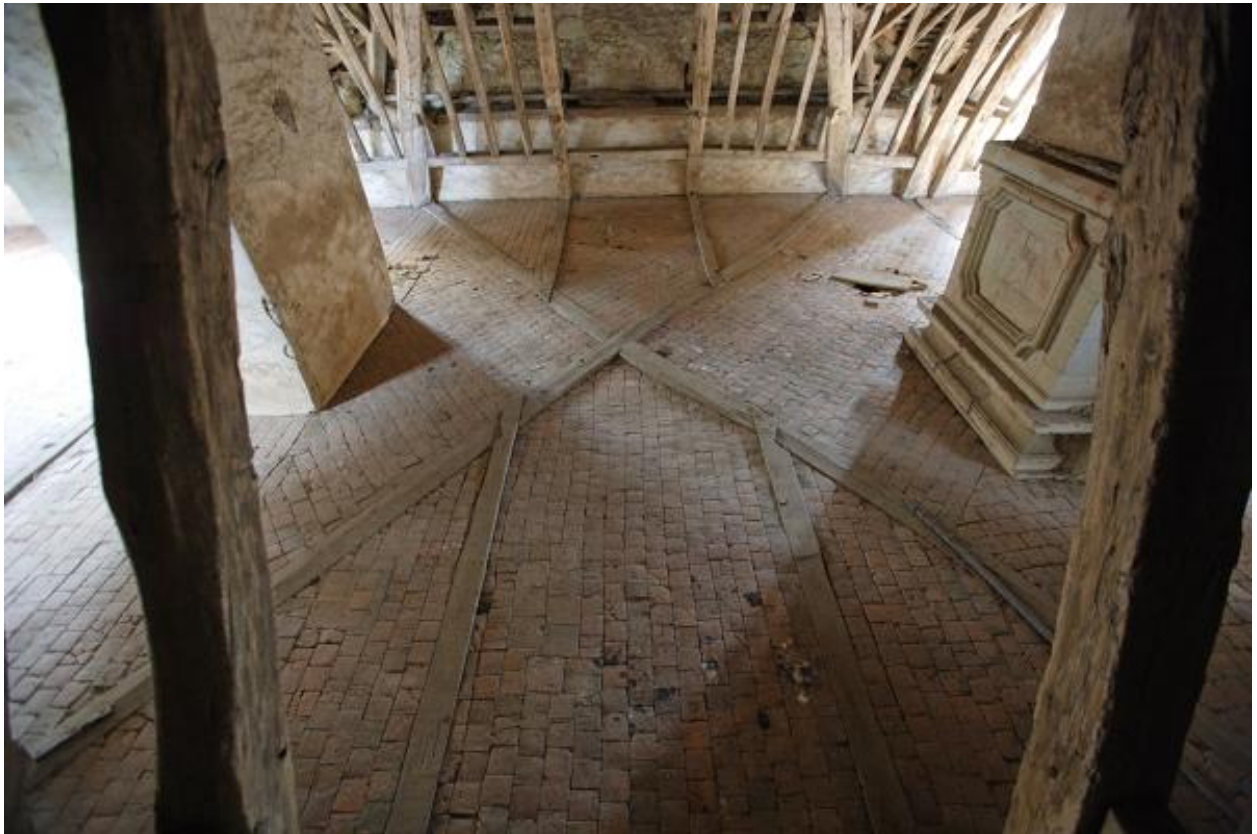
Le grand comble, sol au niveau de la partie centrale.
