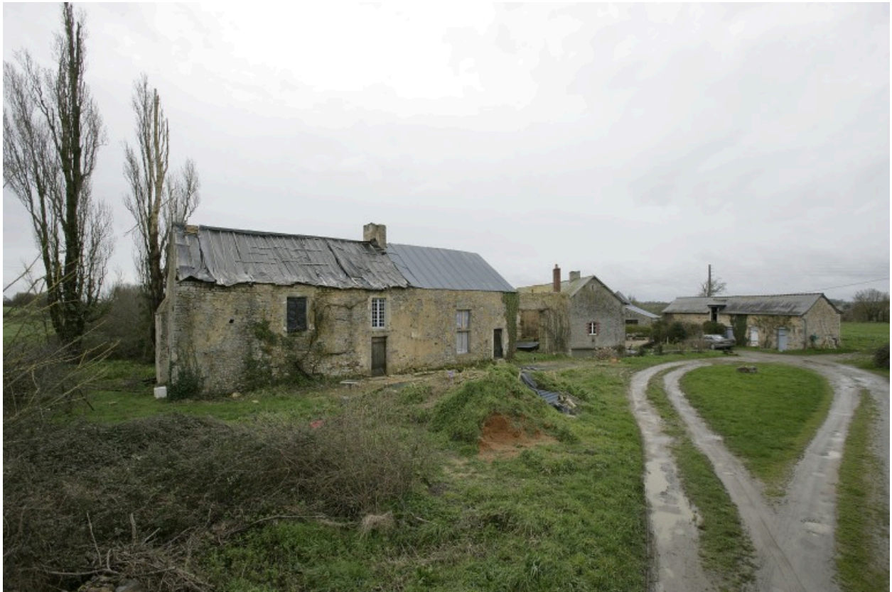
Vue d'ensemble depuis le nord-ouest : le logis manorial, le logis de fermier, la porcherie.
