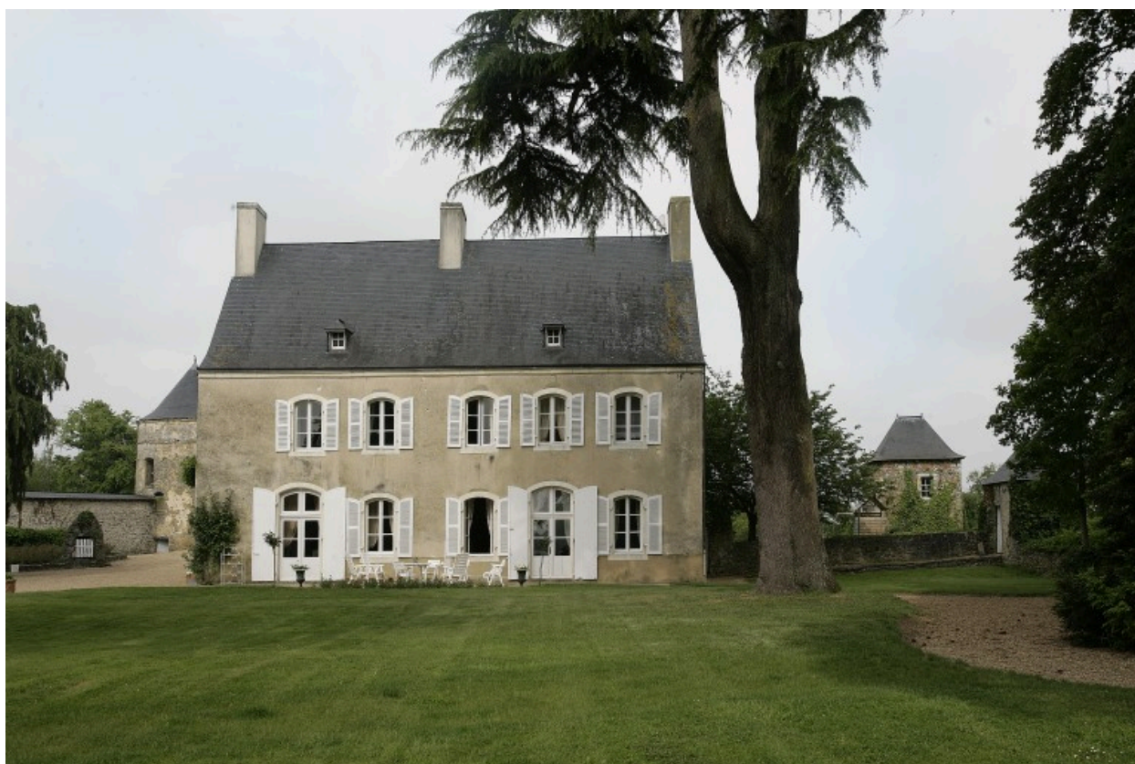
Le logis vu depuis l'est.
