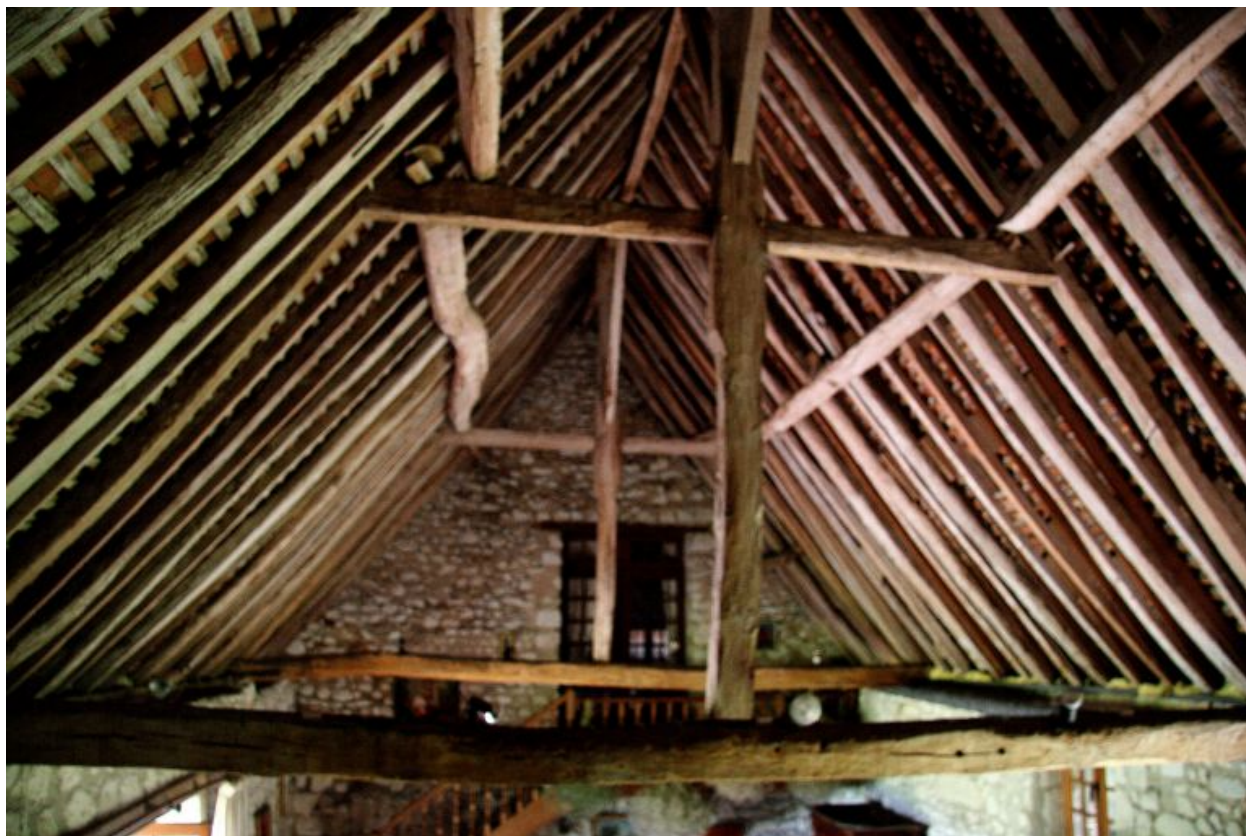
Charpente à pannes avec encoches dans les faux-entrails.
