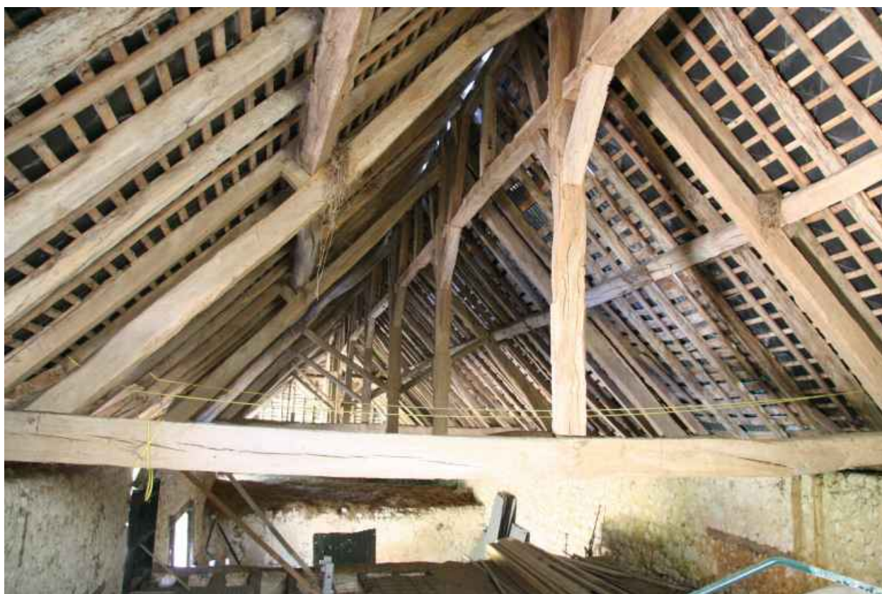
La grange-étable : vue d'ensemble de la charpente.
