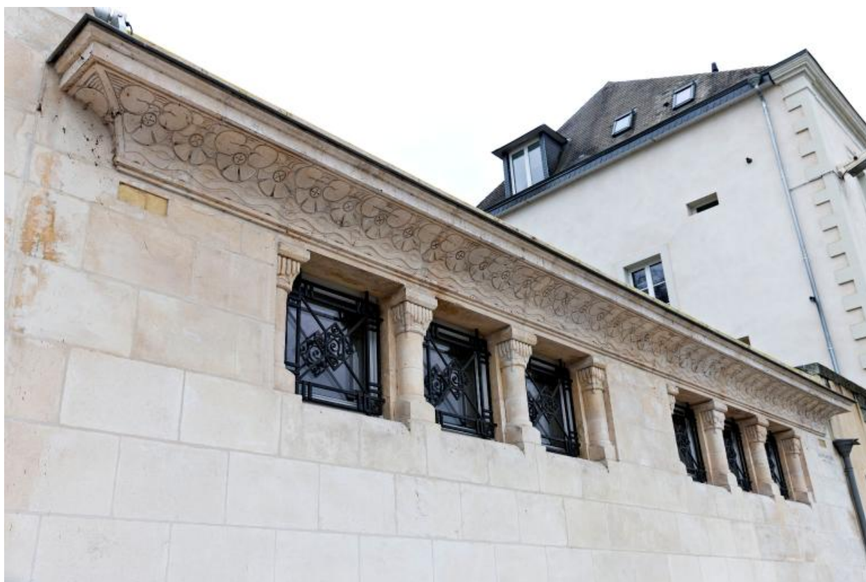
Les bains-douches restaurés. Elévation antérieure, extrémité nord, vue de détail : baies et corniche.
