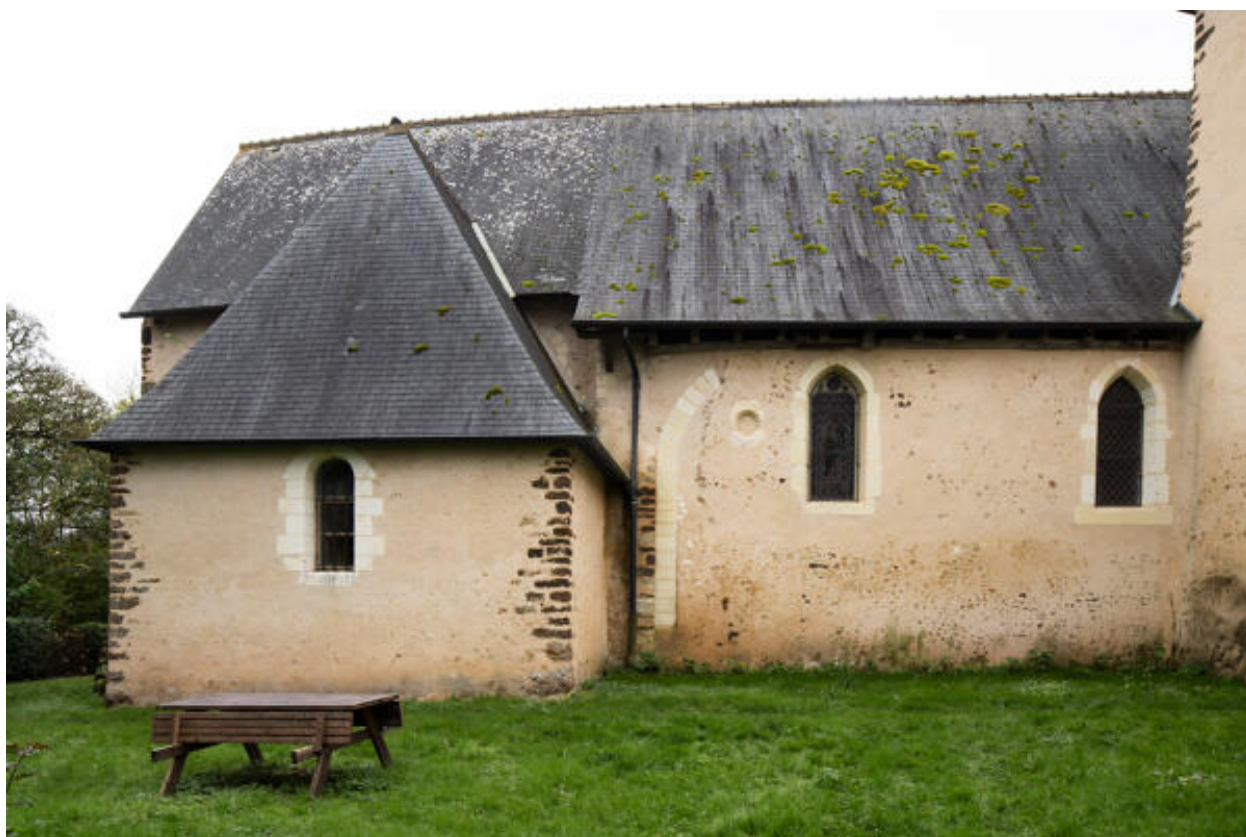
Flanc nord, nef et sacristie.
