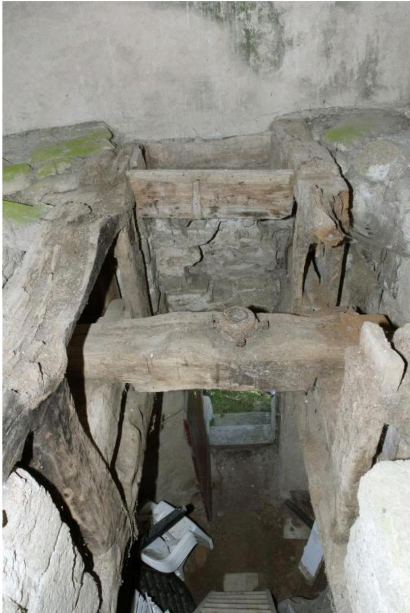
Intérieur de la cage. Vue de la partie supérieure de la trempure, d'ouest en est. À droite, cadre nord, à gauche, cadre sud. Au centre, le palier et sa crapaudine. Au fond, huche de réception de farine.
