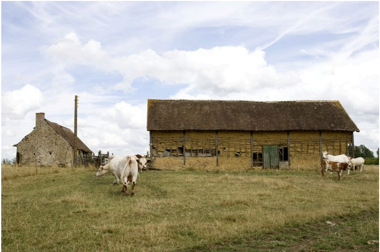
La Pichinière : élévation postérieure de la grange.
