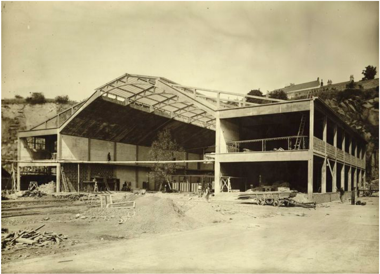
Construction de la canetterie, 1928.
