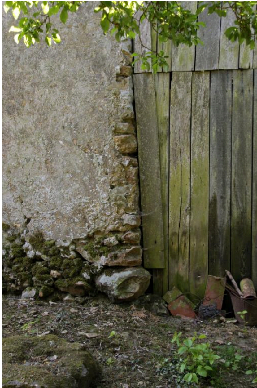
Maison 1 : détail chaînage d'angle façade nord, côté ouest.
