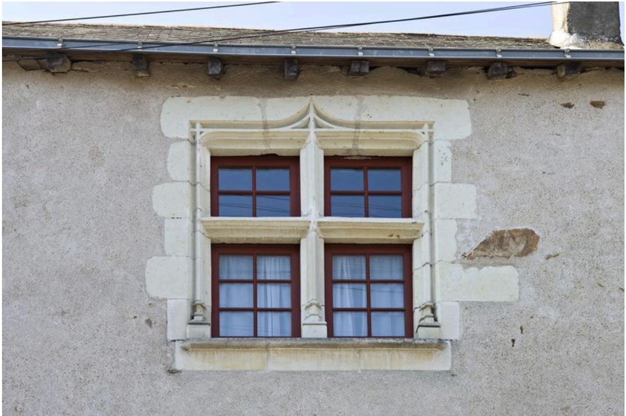
Élévation nord : baie à meneaux ornée, 16e siècle.
