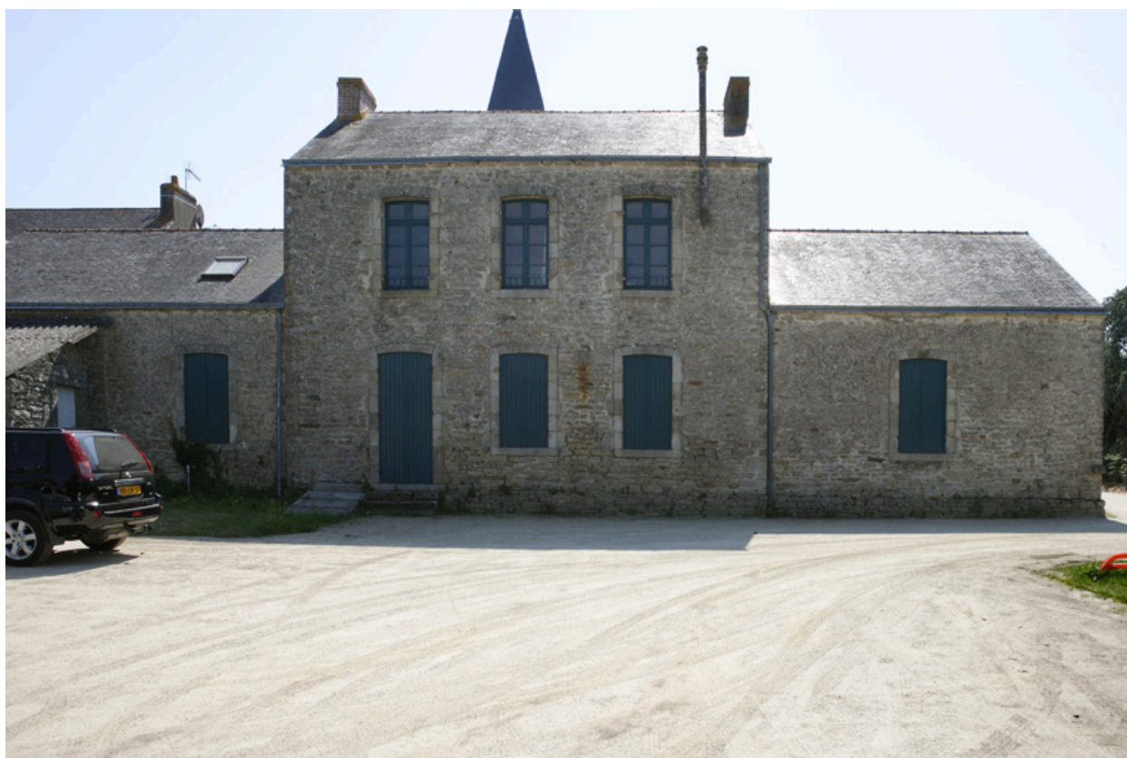
Vue de la façade arrière.
