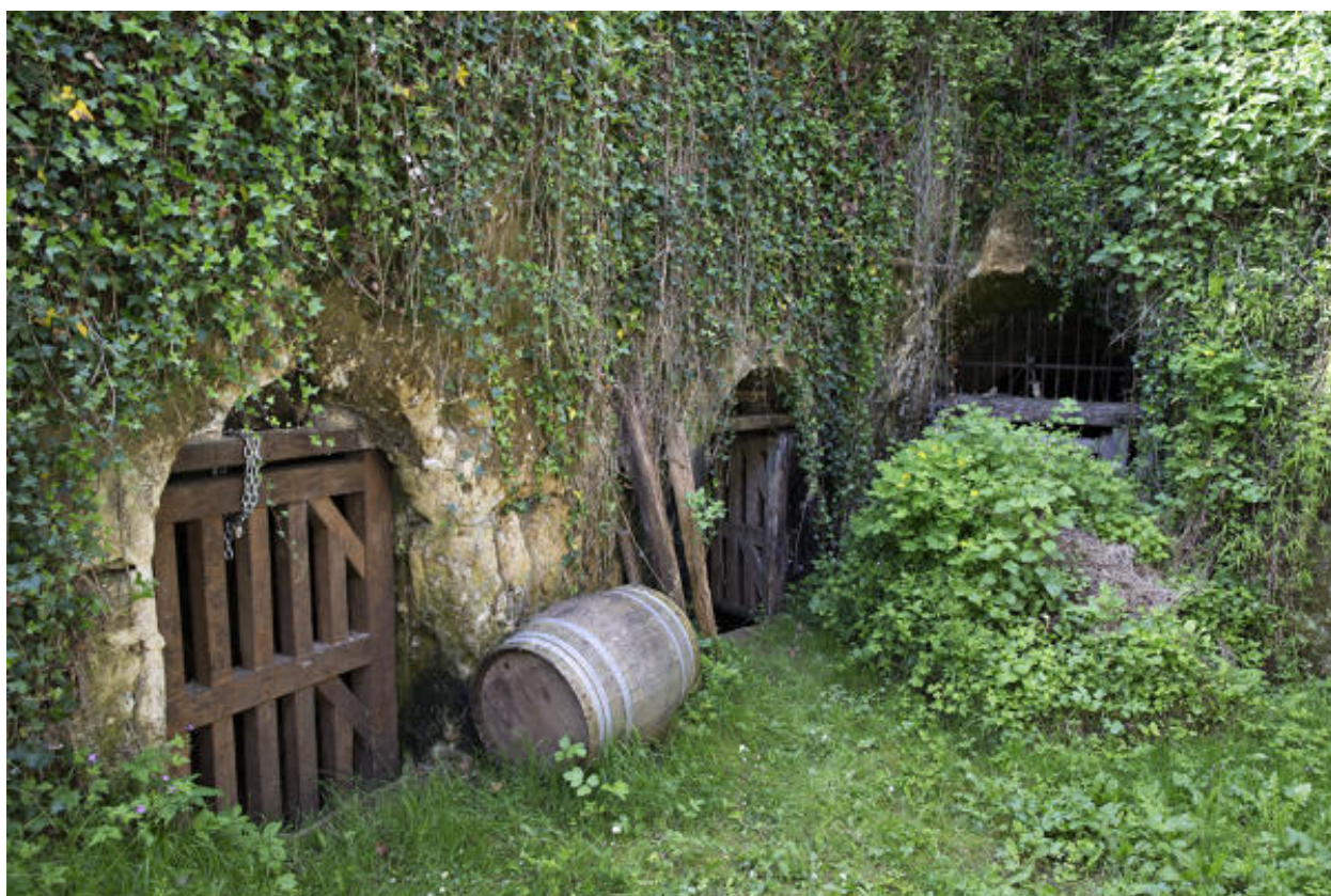
Ruillé-sur-Loir, le Petit Dauvers, sente des Caves : entrées de caves.
