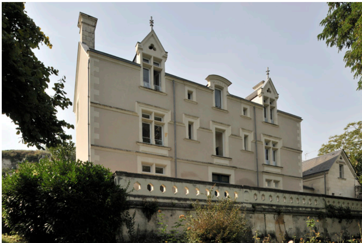
Façade nord (1886), face à la Loire, de style néogothique.
