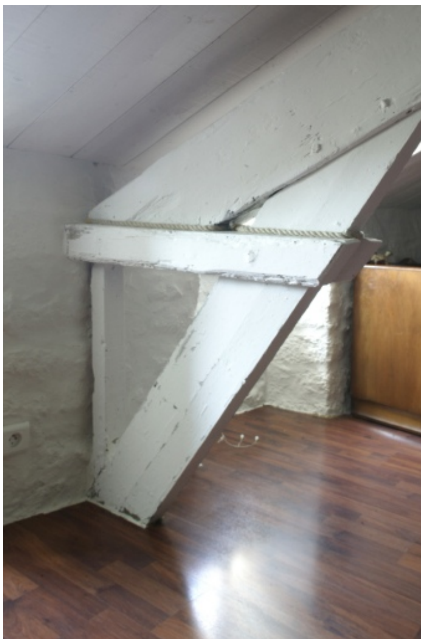
Détail de la charpente de la partie sur jardin.
