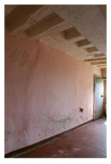
Etage de soubassement. Pièce 2A : le mur nord et le plafond signalant l'emplacement d'un ancien conduit de cheminée.
