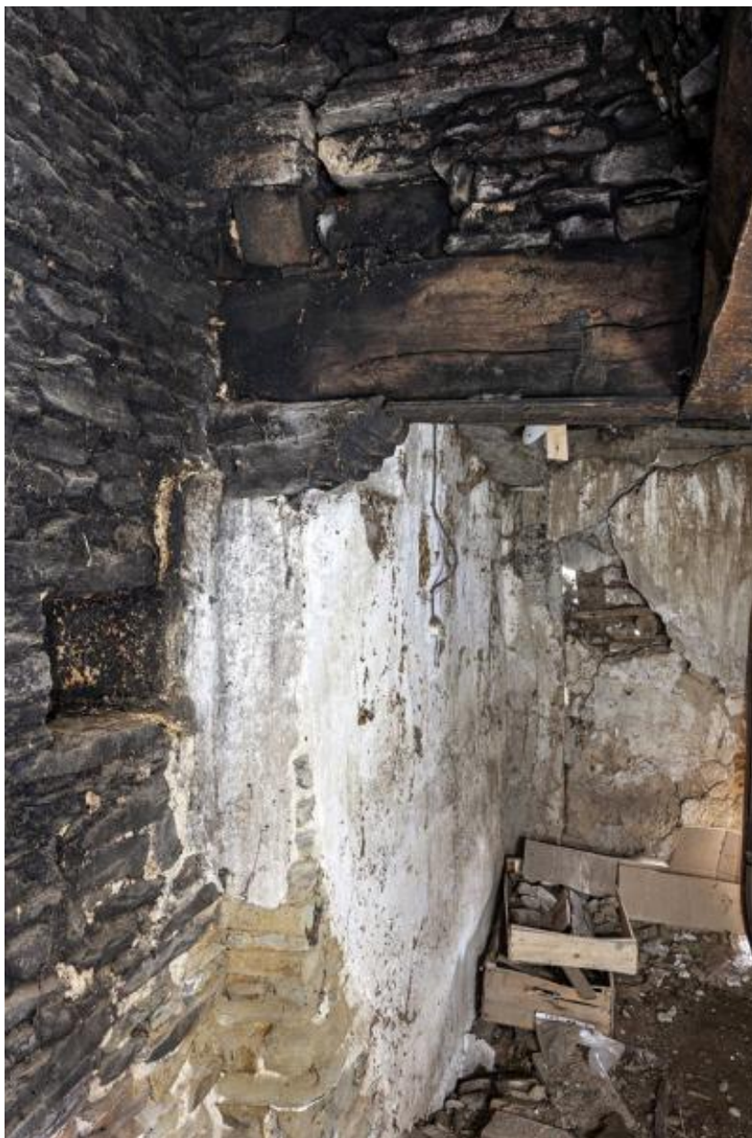
Corbeau droit de la cheminée occidentale.
