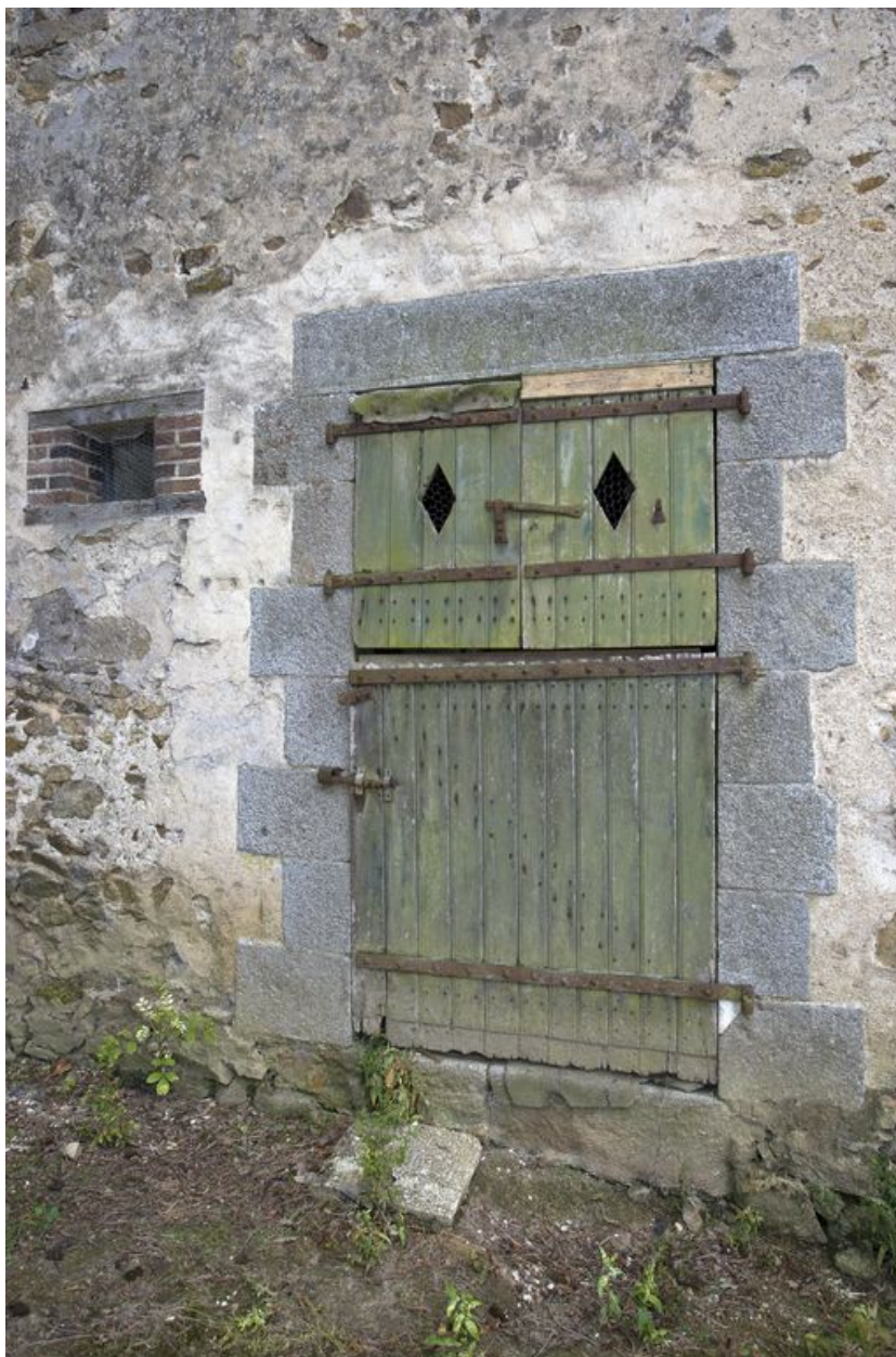
Ecurie-grange : porte à un vantail bas et deux volets hauts.
