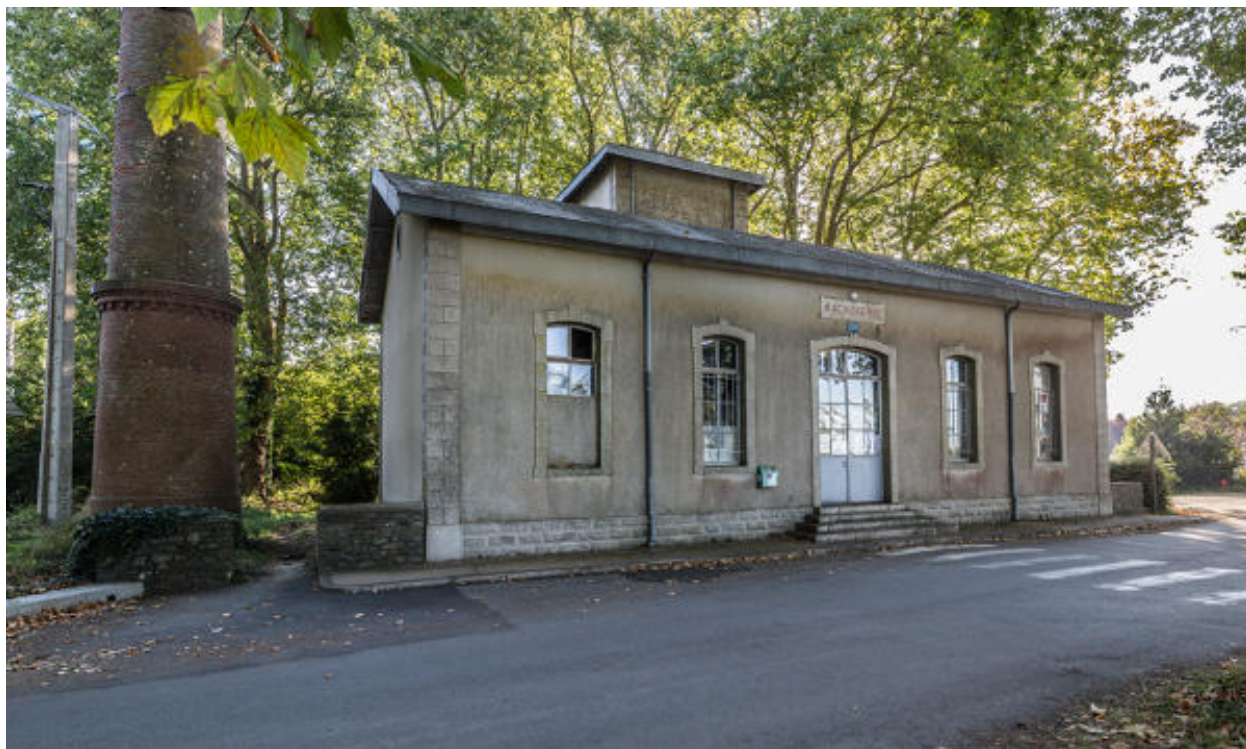
Salle des machines de l'écluse de la Martinière.
