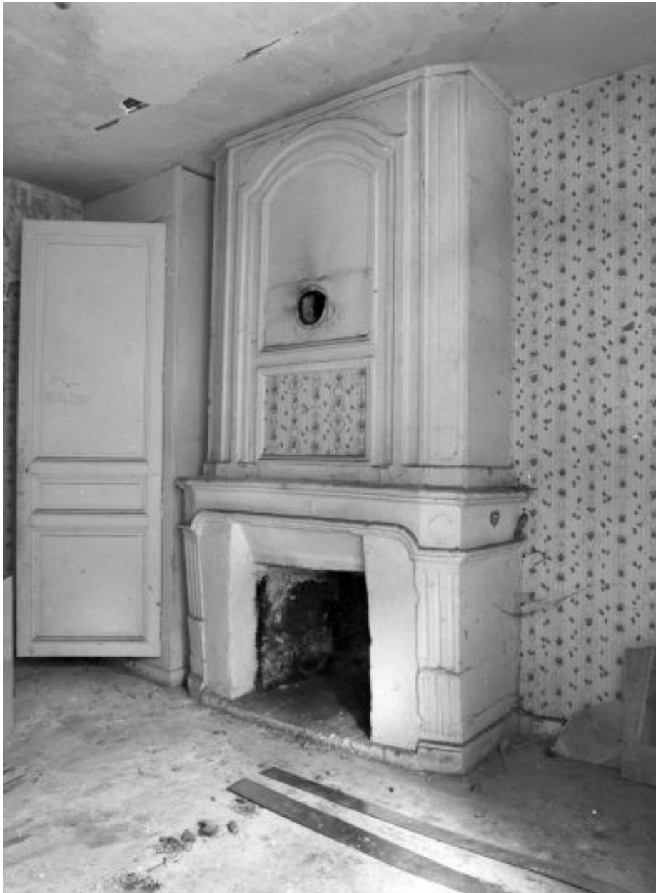
Corps postérieur au 2e étage : mur latéral gauche.
