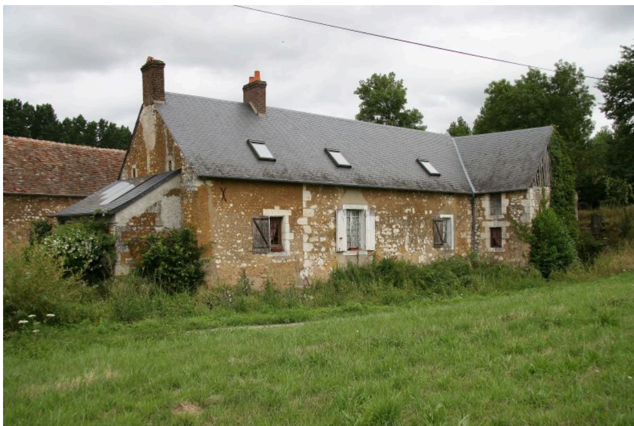
Le moulin : façade sur le bief.
