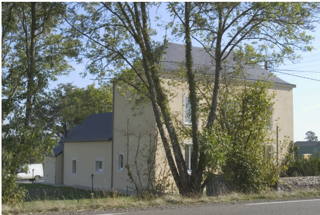
Vue depuis de sud-ouest.
