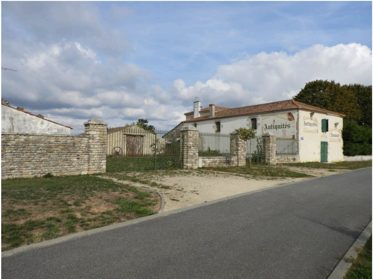
La cour ouest et les anciennes dépendances de Saint-Pic, vues depuis le sud-ouest.
