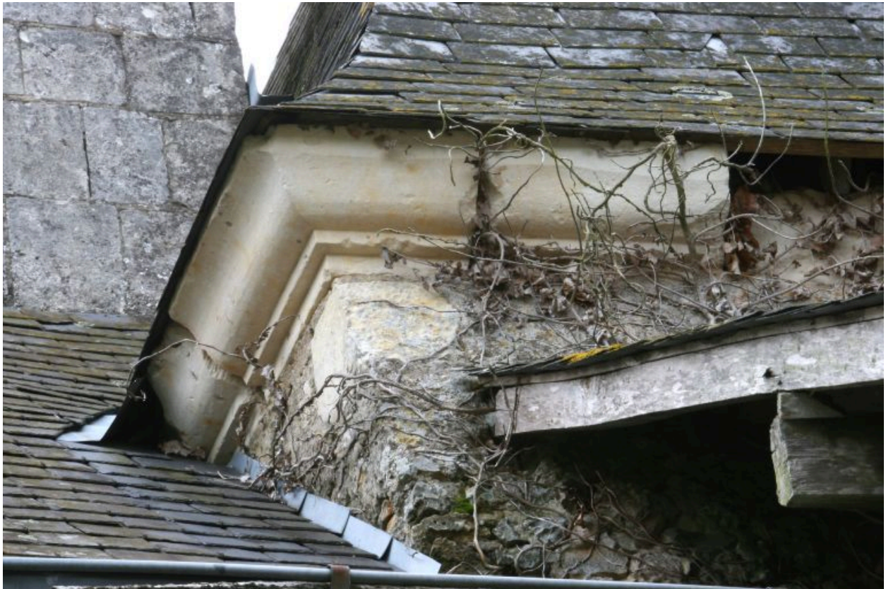
Les communs, pavillon nord-est, face nord : corniche.
